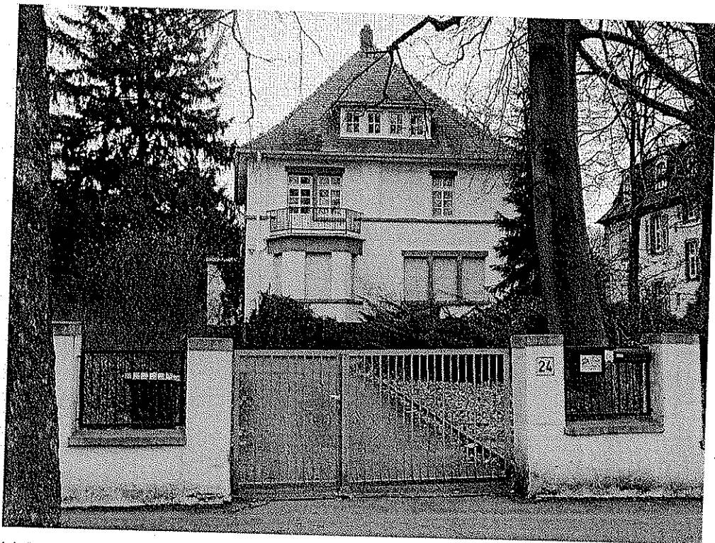
Bild 20: Walmdach mit mittelgroßer Gaube, die ca. ein Drittel der Trauflänge einnimmt - Heidelberger Landstraße 24
