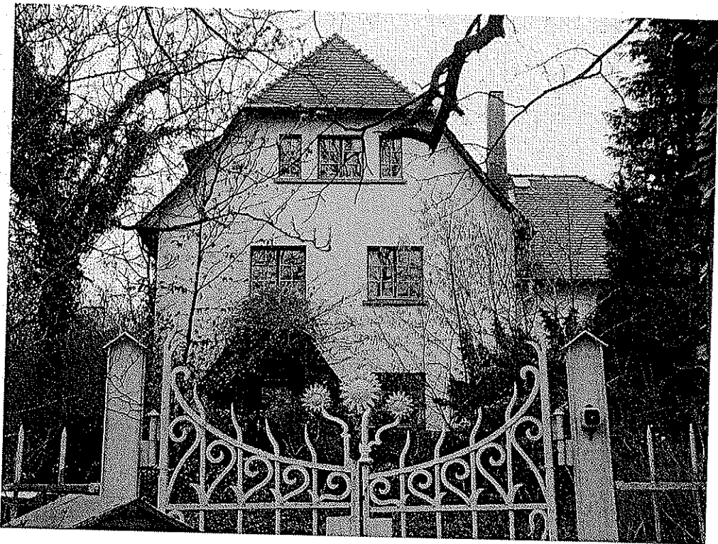
Bild 30: Historische Einfriedung mit zusätzlichen Schmuckformen – Heidelberger Landstraße 4
