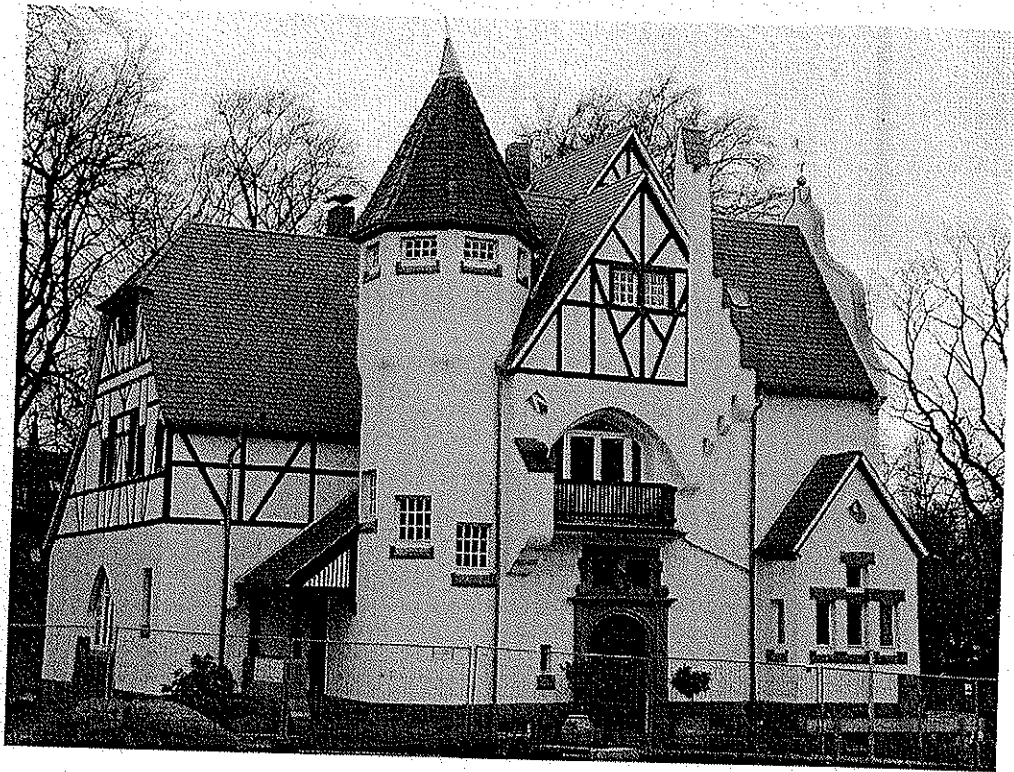
Bild 34: Gebäude mit sehr hoher Gestaltqualität, als Kulturdenkmal unter Schutz gestellt – Villa Alice – Heidelberger Landstraße 12
